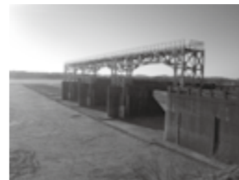
大河津可動堰改築右岸上流護岸他工事完工 ▶ P.47
