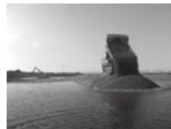
手取川岩内地区急流河川対策その3工事 土砂運搬状況 ▶ P.49
