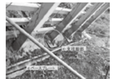
ムーブソールフェンス支柱脚部と ベースプレート設置状況 ▶ P.59
